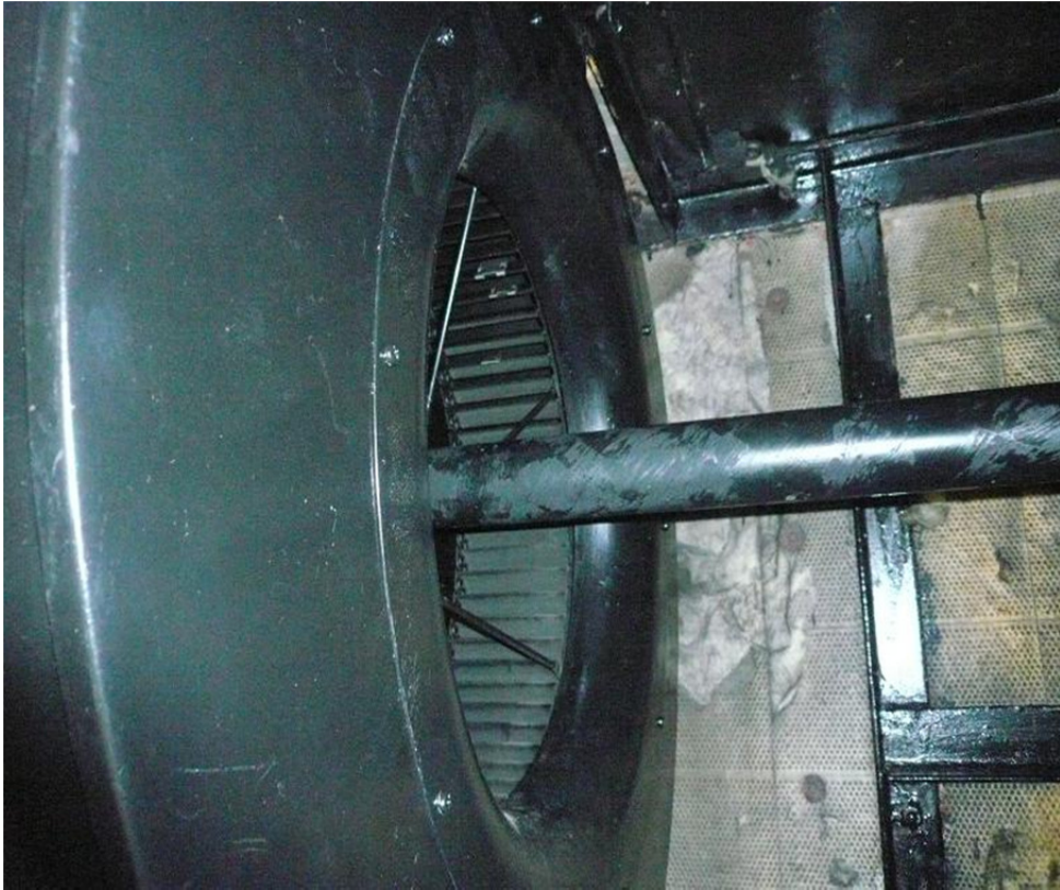
写真 2.8-23 ファン羽根の拡大写真(修理後)
