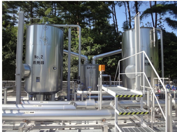
写真 2.11-7 LNG 蒸発器
