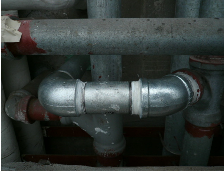
写真 2.8-26 一般排水管拡大写真(修理後)
