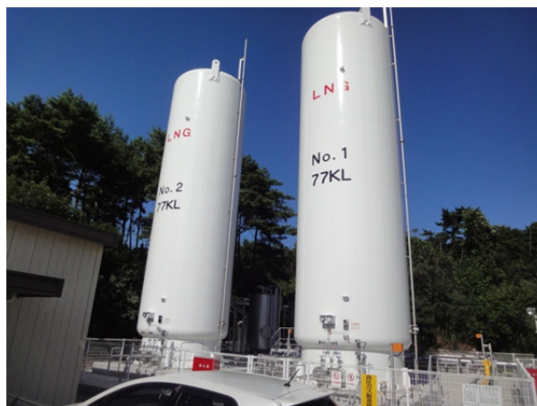
写真 2.11-6 LNG 貯槽
