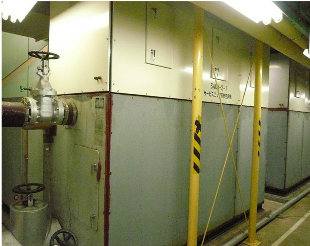
写真 2.8-24 空調機の全体写真(修理後)
