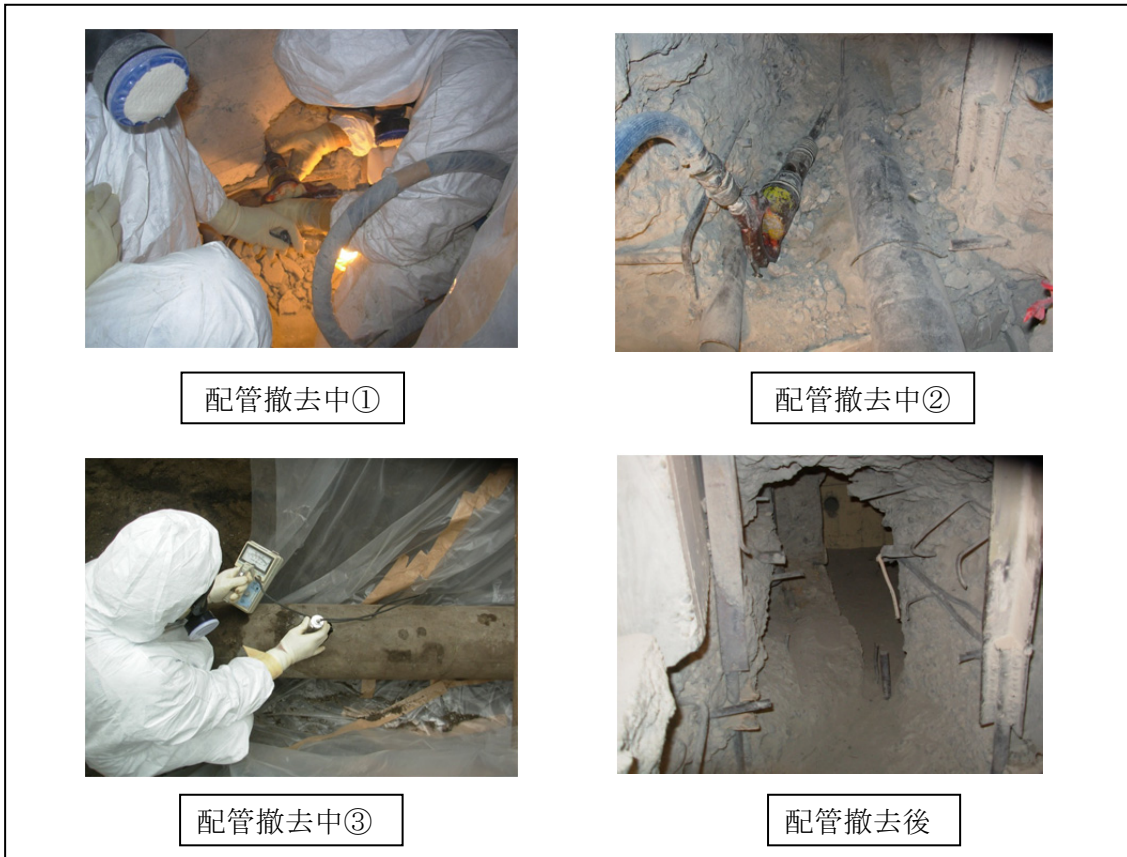
写真 2.11-13 炉室貫通部配管撤去
