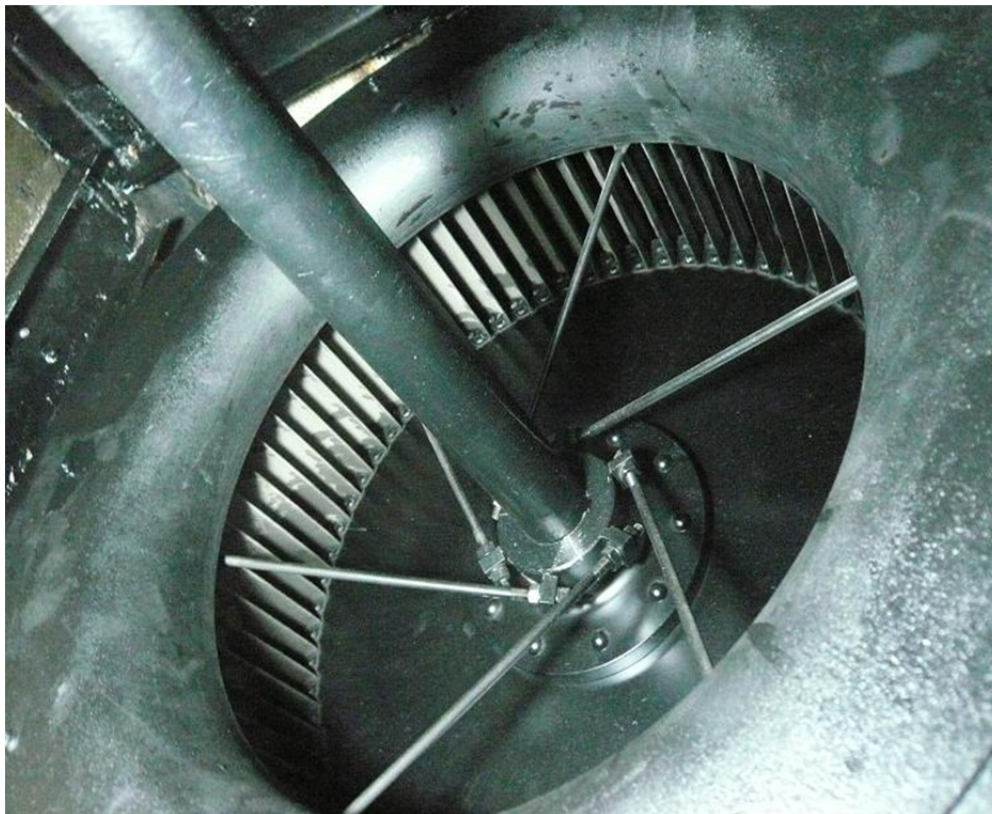
写真 2.8-3 ファン羽根の拡大写真(修理後)
