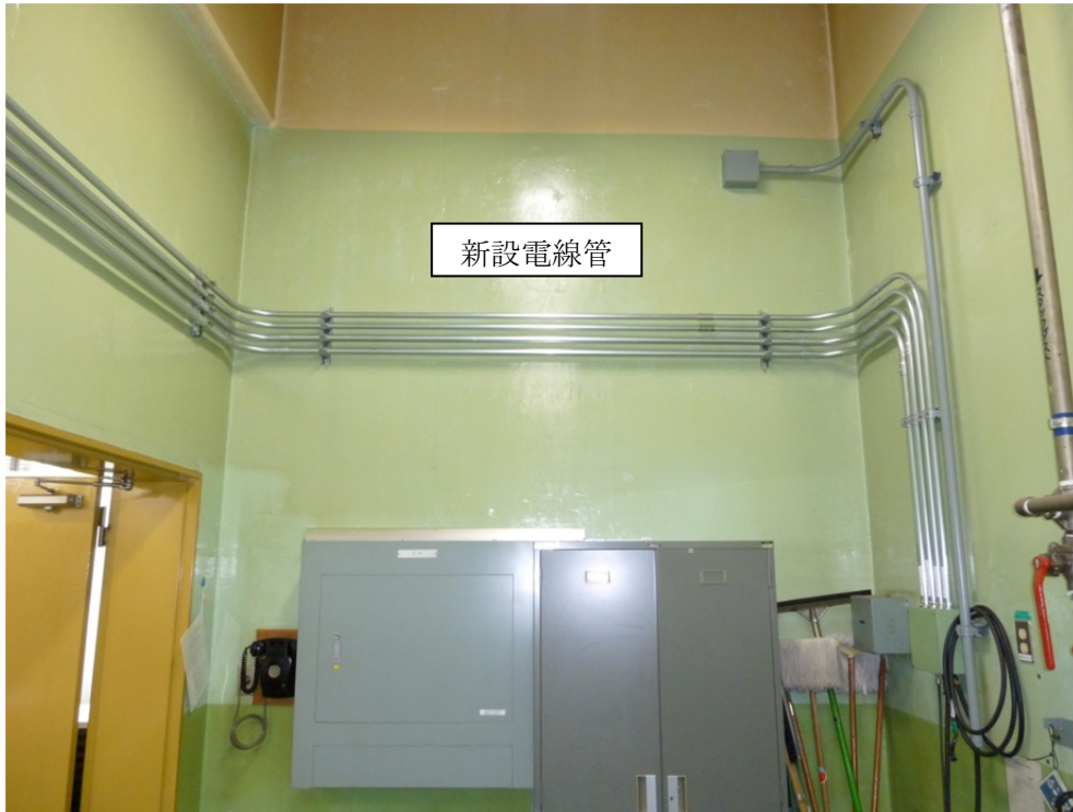
写真 2.8-6 新設敷設電線管写真(修理後)
