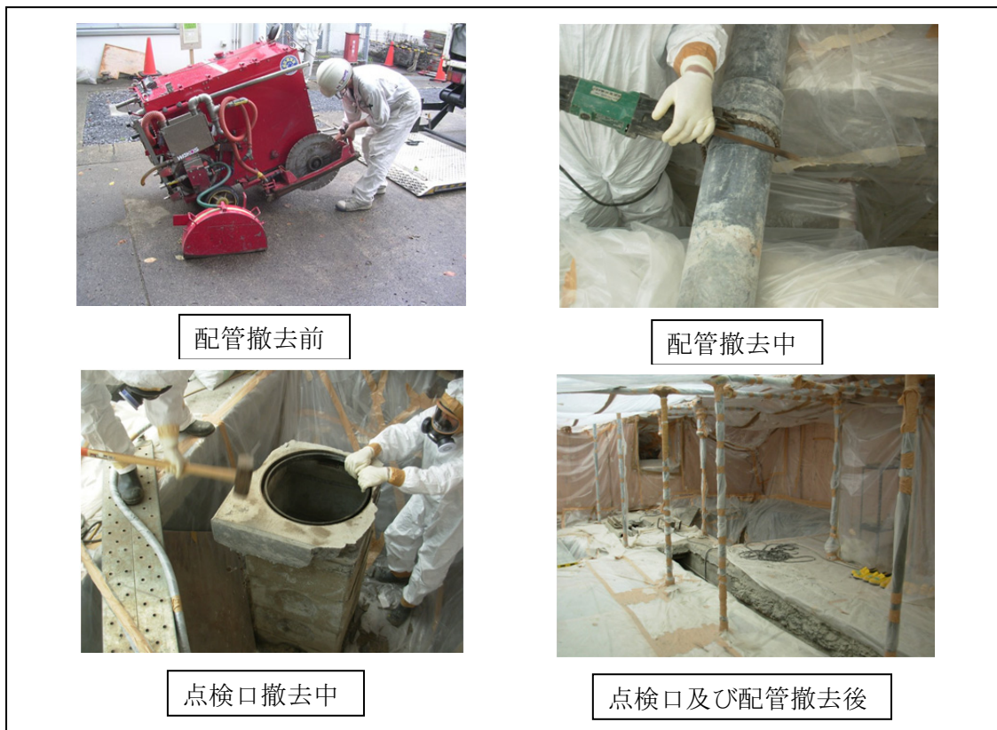
写真 2.11-12 ピット内排水管撤去
