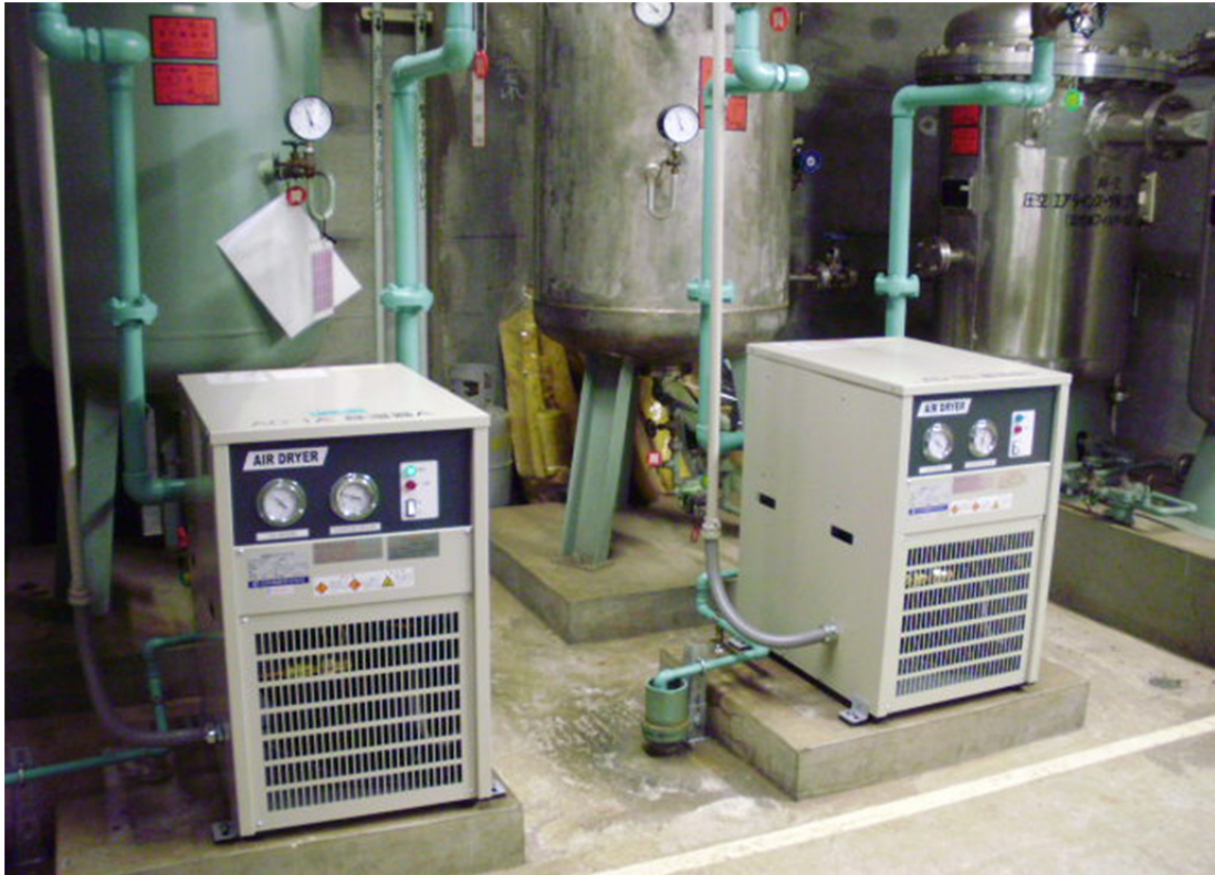
写真 2.8-11 エアードライヤ (修理後)
