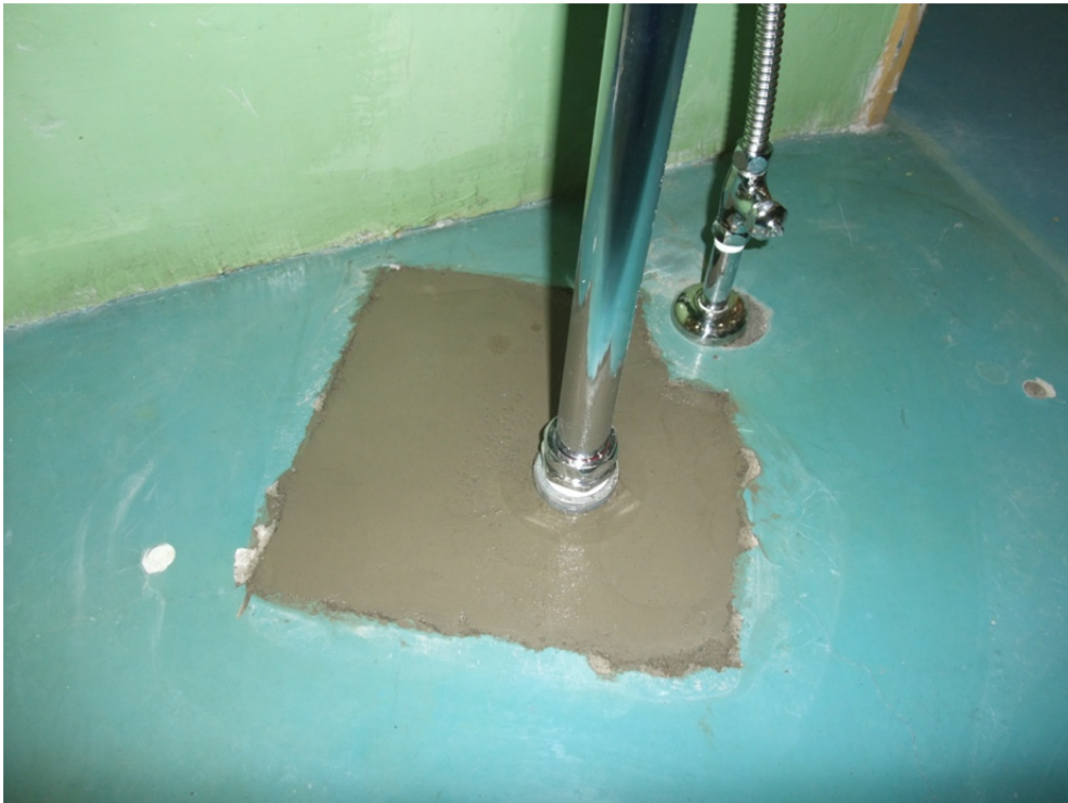
写真 2.8-7 排水管床貫通部補修後写真(修理後)
