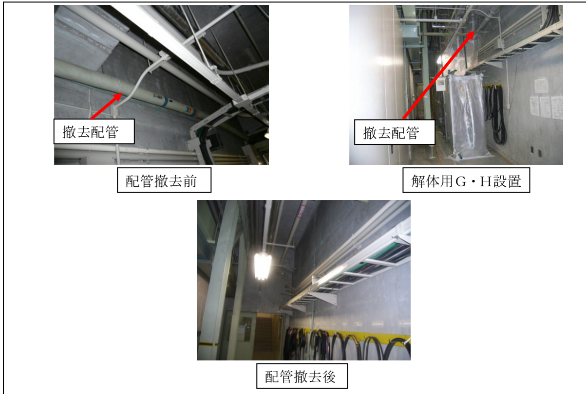
写真 2.11-14 マニプレータ修理室系統
